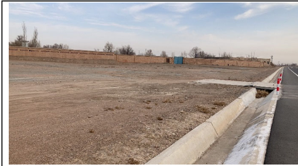
施工营地恢复情况
