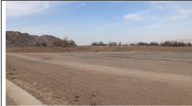
施工营地恢复情况
