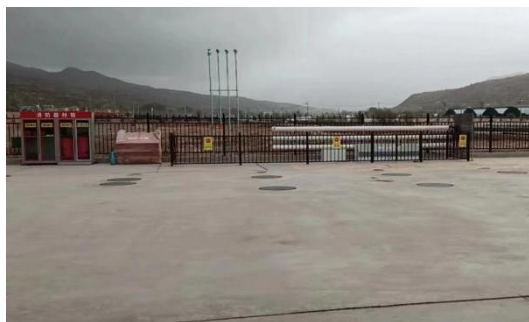
油气回收装置
