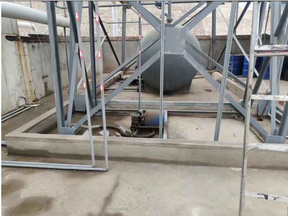
储油罐围堰
